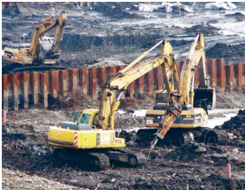
Koncem února začali stavbaři odčerpávat vodu z vyhloubených základů budoucího obchodního centra, začaly i další stavební práce. Foto: Multi Development
